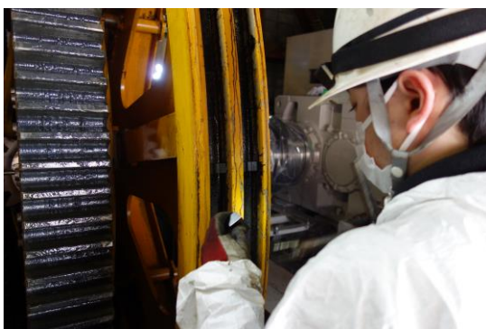
原動滑車ゴムライナー交換工事
